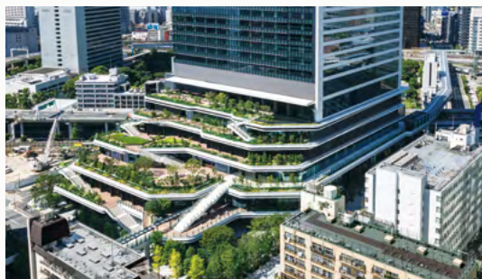
東京ポートシティ竹芝 (2020年5月竣工)
