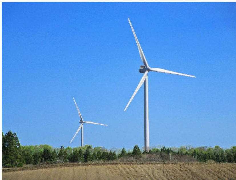
リエネ六ヶ所村千歳 風力発電所
