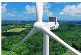
リエネ六ヶ所村千歳風力発電所
