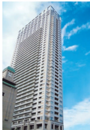
プラザタワー勝どき
