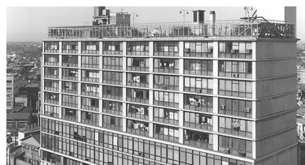
東急スカイライン
