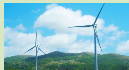
リエネ松前風力発電所
