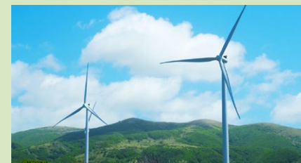
リエネ松前風力発電所
