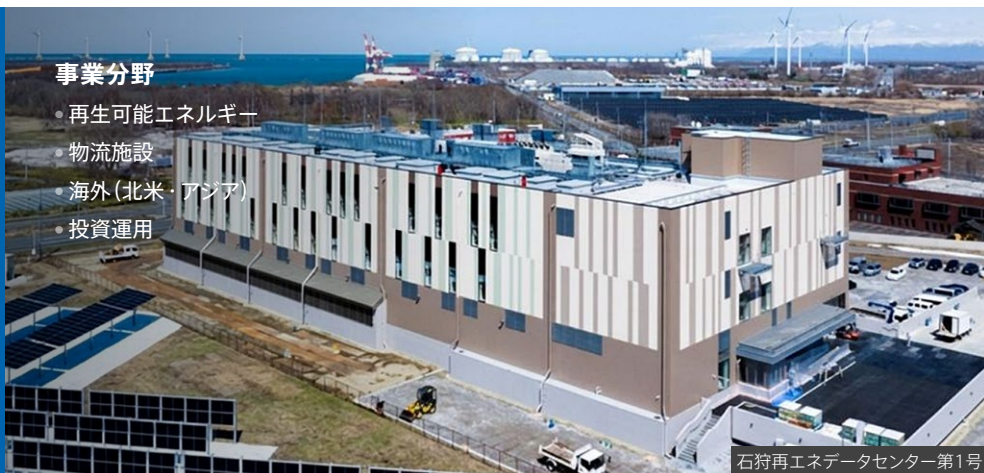
石狩再生エネデータセンター第1号
