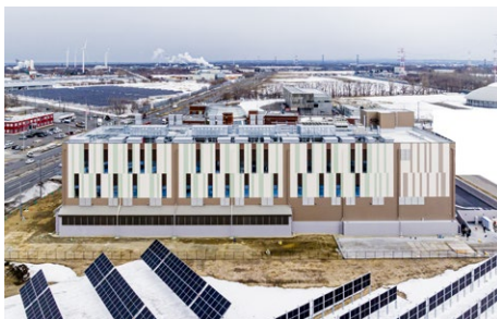
2026年3月に竣工した石狩再エネデータセンター第1号
