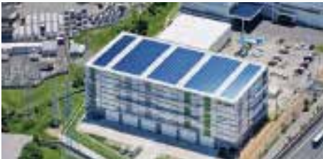
需要家起点での再エネ開発を推進するPPAモデル 「リエネLOGI'Q枚方太陽光発電所」
