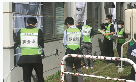
北広島市で、建物の被害写真を使い損傷程度の判定訓練を実施
