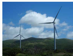
リエネ松前風力発電所
