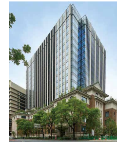
九段会館テラス 東京都千代田区
