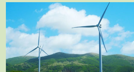
リエネ松前風力発電所
