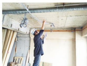
①施工前の点検・検査
