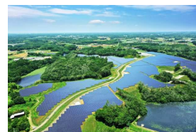
リエネ行方太陽光発電所
