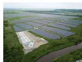
すずらん釧路町太陽光発電所
