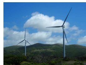
リエネ松前風力発電所
