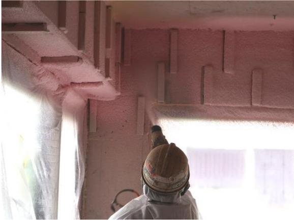
③開口部周辺の壁面に発泡ウレタンの吹付け【施工中】
