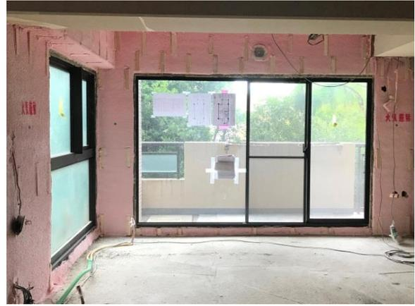
④発泡ウレタン断熱改修が完了した状態【施工後】
