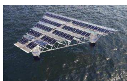
<発電> 洋上太陽光発電設備 発電容量 80-100kW
