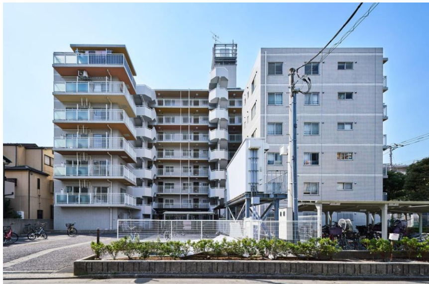
北側外観（撮影：黒岩翼写真事務所）
