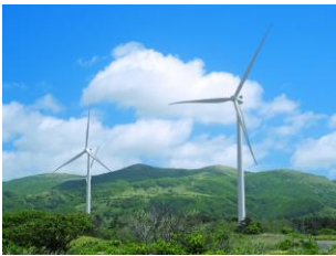
リエネ松前風力発電所 (北海道松前町)
