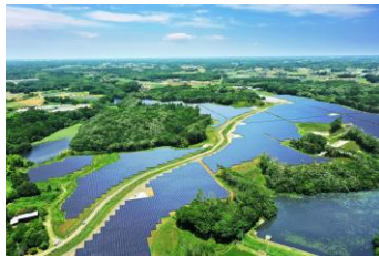
リエネ行方太陽光発電所 (茨城県行方市)
