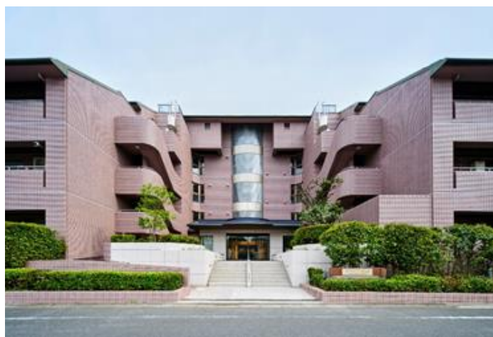
・改修後の外観
