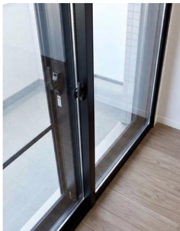
・内窓の設置
