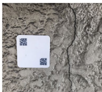
① 検査画像を撮影 ※配置幅を一定にしたQRコードを用いて撮影距離を補正します。
