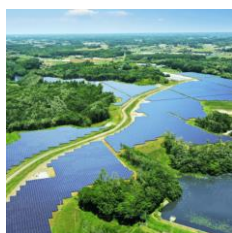
リエネ行方太陽光発電所 （茨城県行方市）
