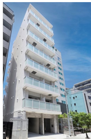
レガシア目黒リバーコート 外観写真 (2025年6月撮影)
