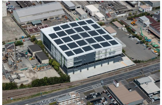
屋上の太陽光パネル
