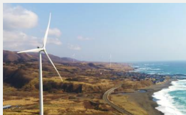
リエネ松前風力発電所
