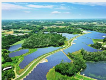
リエネ行方太陽光発電所 (茨城県) 定格容量：28MW (2021年3月期運転開始)
