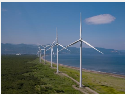
リエネ銭函風力発電所（北海道）：34MW
