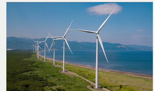
リエネ銭函風力発電所(北海道)：34MW
