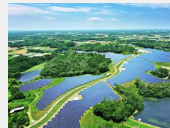
リエネ行方太陽光発電所 （茨城県） 定格容量：28MW （2020年度運転開始）
