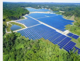
リエネ長南太陽光発電所 （千葉県） 定格容量：24MW （2020年度運転開始）
