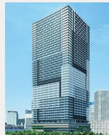
グランス タワ-豊洲 (2021年10月竣工予定)
