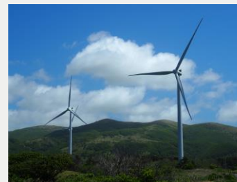
リエネ松前風力発電所 （北海道） 定格容量：41MW （2019年度運転開始）
