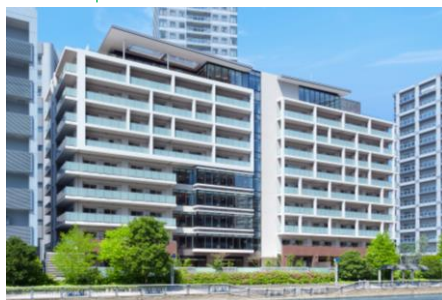
グランクレール芝浦 シニア住宅 2020年7月開業
