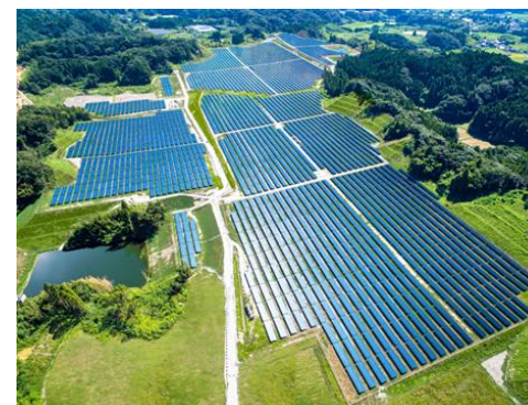
リネ長南太陽光発電所(千葉県) : 24MW (2020年7月運転開始)
