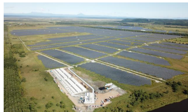
すずらん釧路町太陽光発電所：92MW (2020年2月運転開始)
