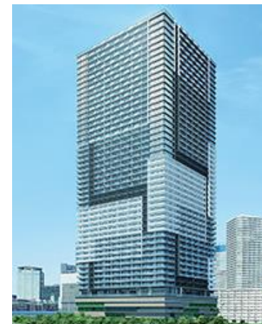
プラズ*ター豊洲 (2021年10月竣工予定)
