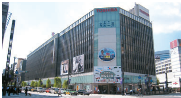
銀座東芝ビル 所在：東京都中央区銀座五丁目 延床面積：約40,400m 2
