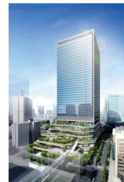
オフィスタワー (A 街区) 用途：オフィス/商業 延床面積：約180千㎡(業務棟) 竣工：2020年5月(業務棟)
