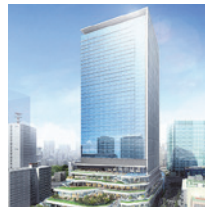
(仮称)竹芝地区開発計画 港区 オフィス/商業/住宅 延床面積：201千㎡
