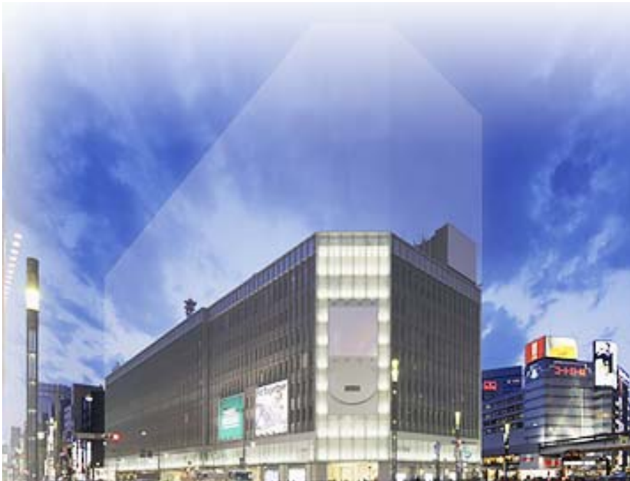
〈Former Ginza TS Building〉
