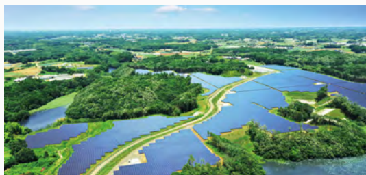
リエネ行方太陽光発電所（2020年10月運転開始）
