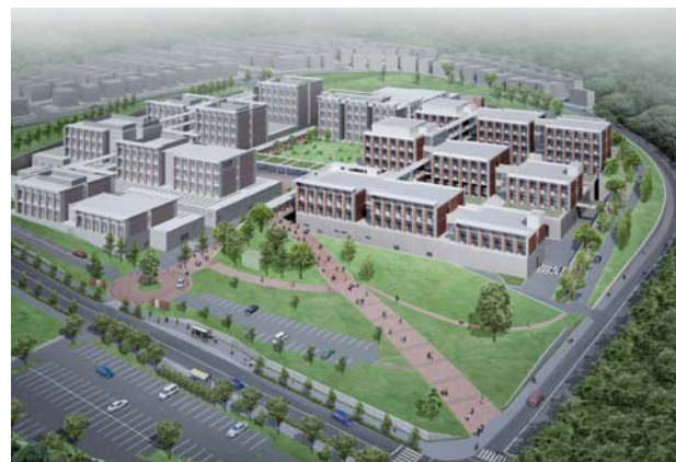
京都大学(桂)総合研究棟Ⅲ(物理系)等施設整備事業
