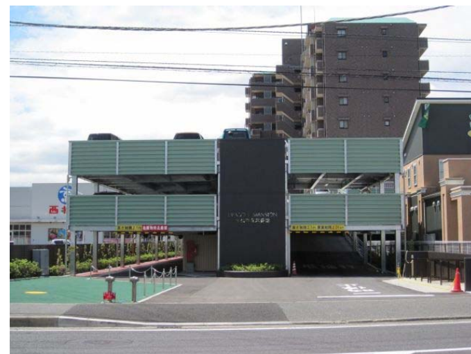
施工後（自走式駐車場に建替え）
