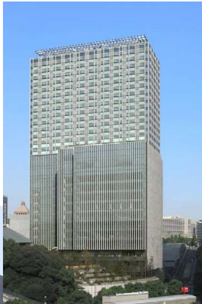
東急キャピトルタワー
