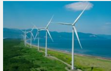
風力発電施設
