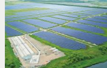
太陽光発電施設
