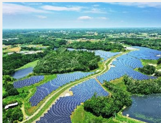
リエネ行方太陽光発電所 (茨城県)
