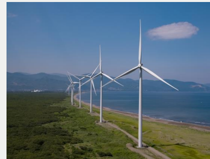
リエネ銭函風力発電所 (北海道) 定格容量：34MW
