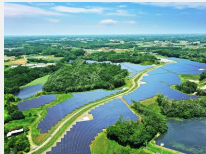
リエネ行方太陽光発電所 (茨城県) 定格容量：28MW
