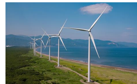
リエネ銭函風力発電所：34MW
