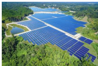
リエネ長南太陽光発電所
