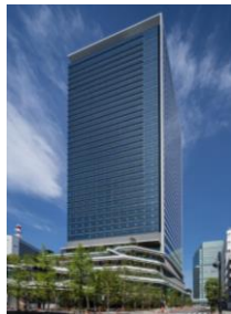
東京ポートシティ竹芝 港区 オフィス/商業/住宅 延床面積：201千㎡
