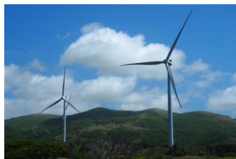
リエネ松前風力発電所
