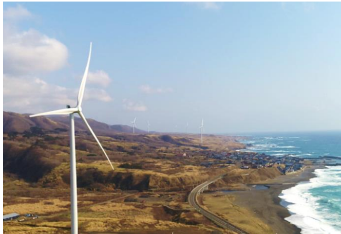
リエネ松前風力発電所 (2019年4月3日運転開始)
