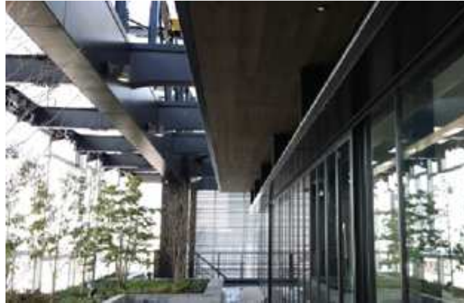
11階テラスの軒天に間伐材を利用
