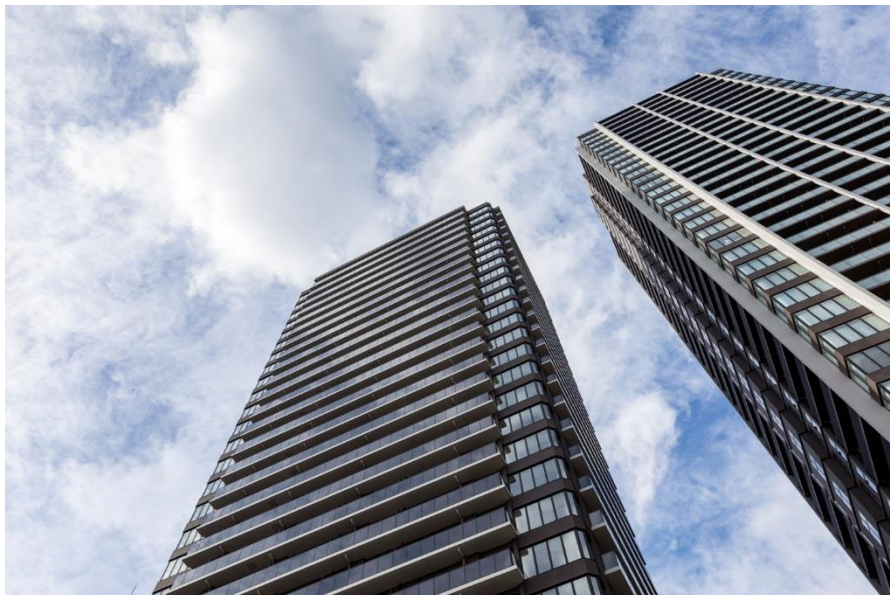
竣工写真(写真左:ブランズタワー・ウェリス心齋橋 SOUTH・ 写真右:ブランズタワー・ウェリス心齋橋 NORTH)
