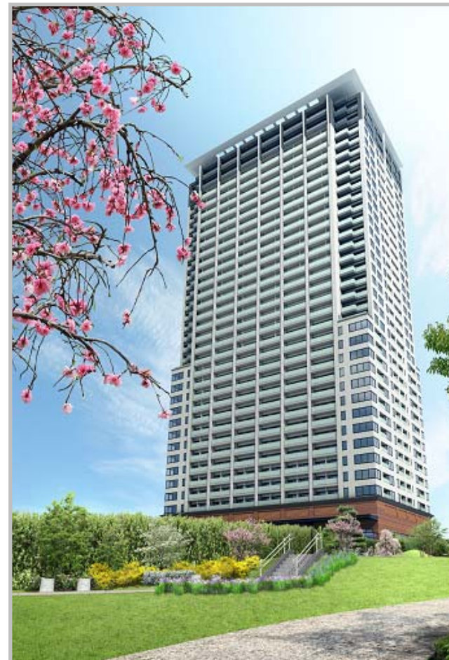
クロスエアタワー (目黒区:池尻大橋駅5分) 総戸数689戸 2013年2月引渡予定 シェア 30%
